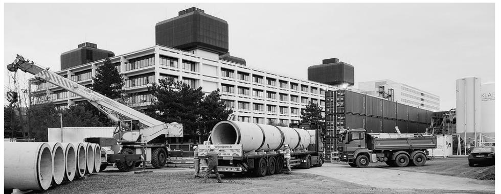
Abladen der Stahlbetonvortriebsrohre DN 1400/DA 1700. Im Hintergrund das Universitätsklinikum Göttingen.
